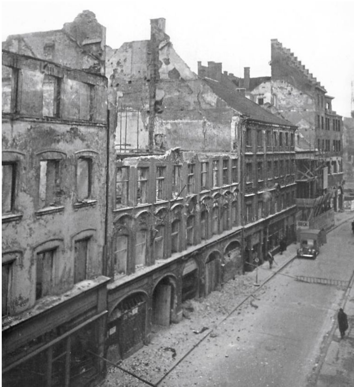
In der Dienerstraße sind im Zweiten Weltkrieg viele Bomben gefallen. Eine traf auch das Dallmayr-Haus. Die Schäden blieben Jahre bestehen. Hier ein historisches Foto des Straßenzuges vom 20. Januar 1949. Stadtarchiv
